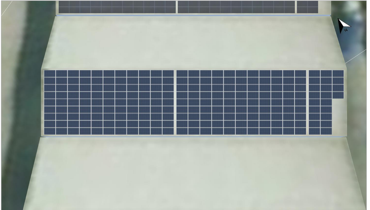
Resim: 12. Modül Alanı - Building 14-Roof Area Southwest
